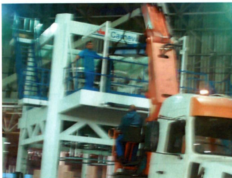
Figura 28 - Utilização de guindaste na desmontagem de estrutura metálica de estande de dois andares (Arquivo pessoal)
