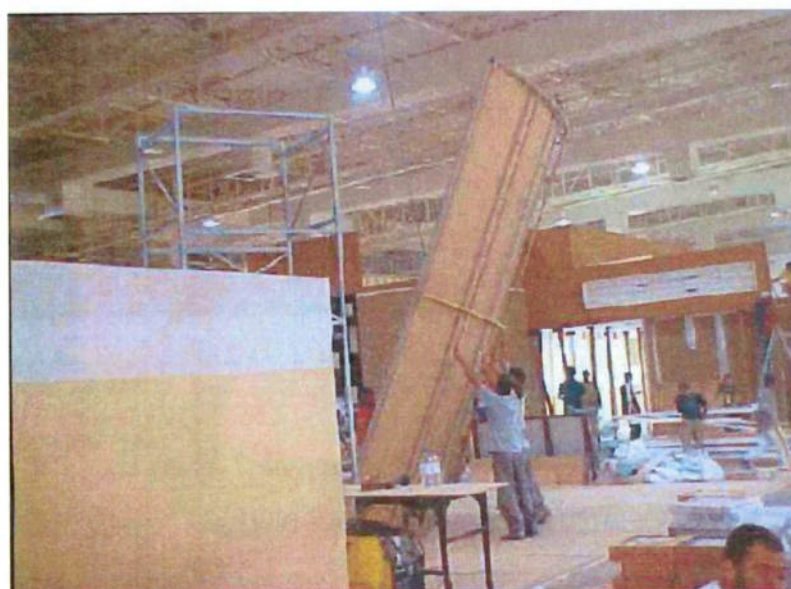
Figura 12 – Montagem de paredes de dois pavimentos (Arquivo pessoal)
