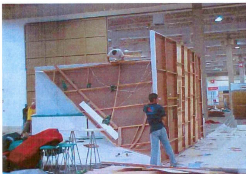
Figura 27 – Desmontagem das paredes (Arquivo pessoal)
