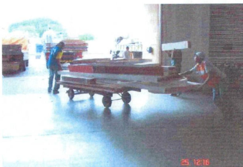
Figura 33– Transporte de paredes pré-montadas em TS (Arquivo pessoal)
