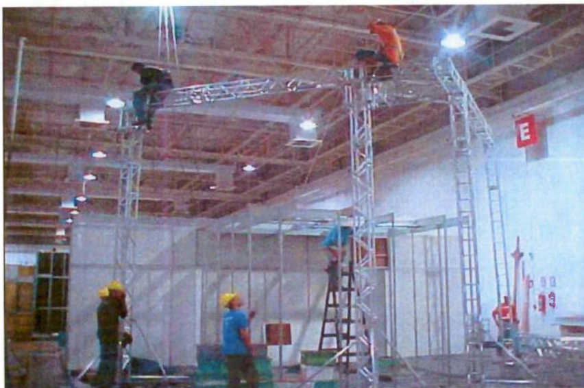
Figura 10 - Montagem de teto com estrutura metálica (Arquivo pessoal)
