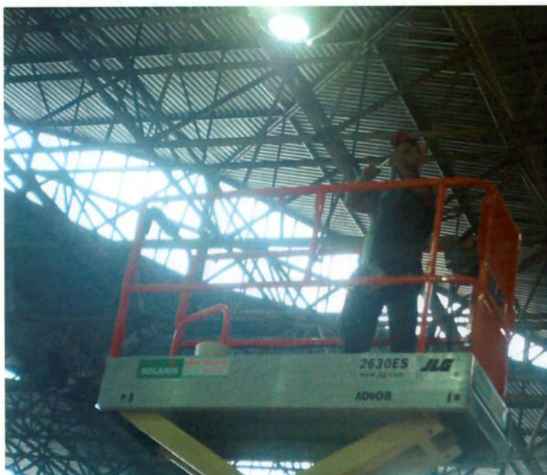
Figura 29 - Desmontagem de estrutura metálica e sistema elétrico no teto do pavilhão (Arquivo pessoal)
