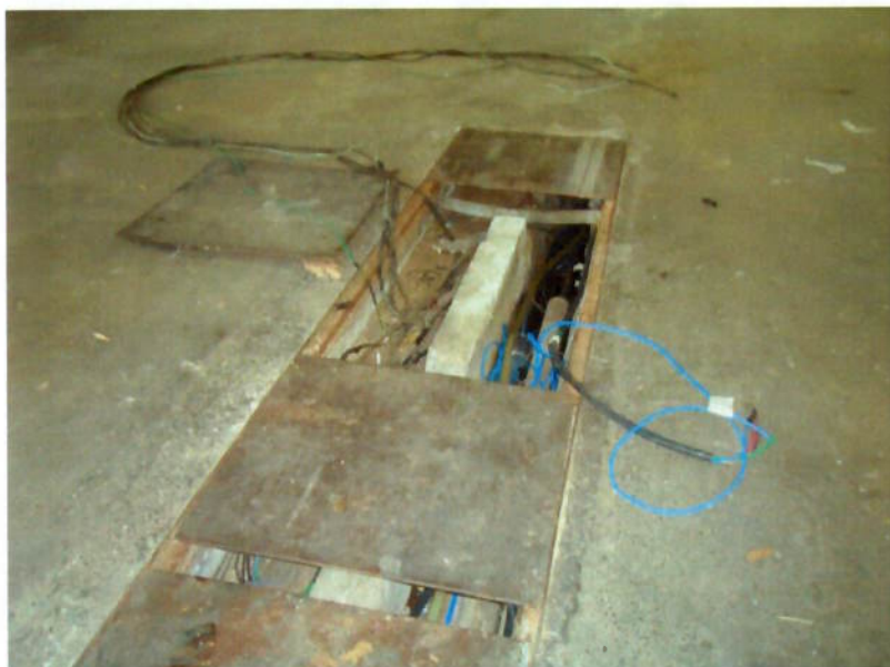
Figura 6 – Instalação da rede hidráulica e elétrica em canaletas subterrâneas (Arquivo pessoal)
