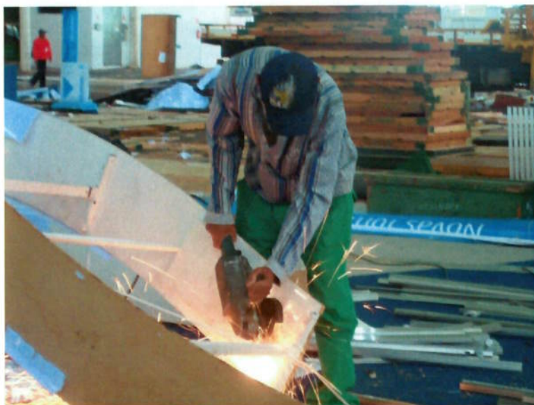
Figura 30 – Desmontagem com serra elétrica, das estruturas metálicas que exigiram solda na montagem (Arquivo pessoal)
