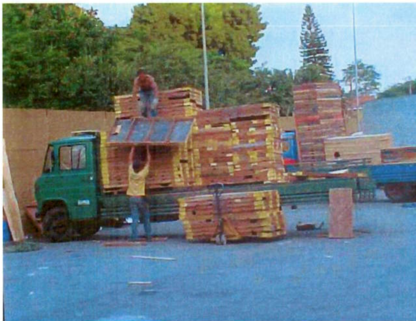
Figura 35 – Carregamento do piso de madeira na fase de desmontagem (Arquivo pessoal)
