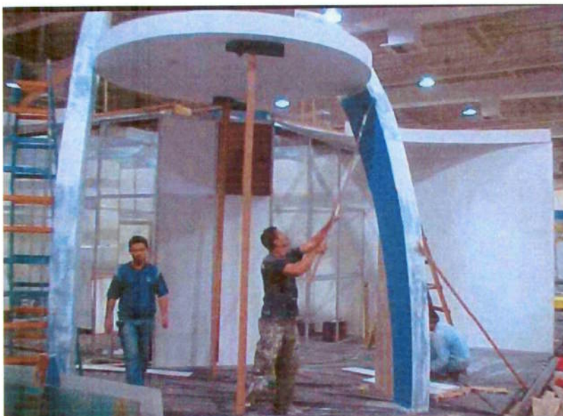
Figura 16 – Pintura das paredes, sem proteção de EPI (Arquivo pessoal)
