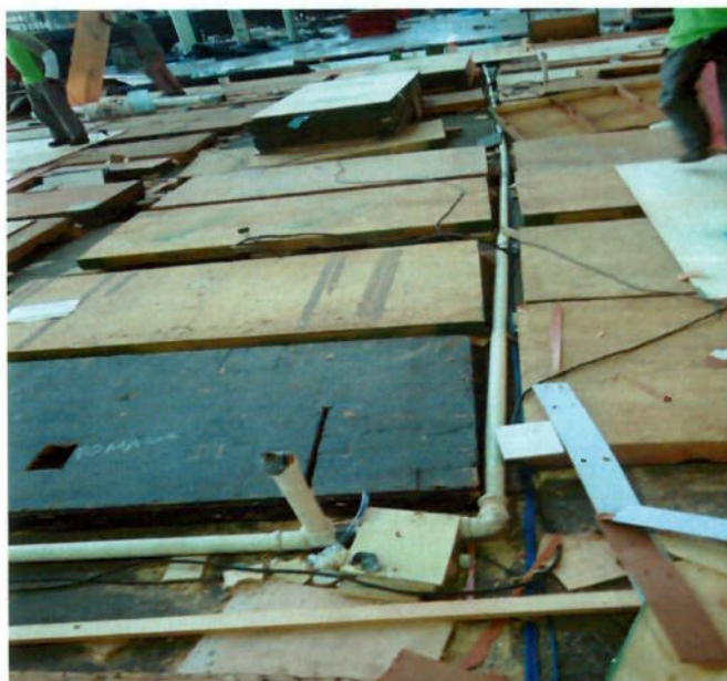
Figura 32 – Desmontagem do piso e início da retirada da tubulação Hidráulica (Arquivo pessoal)
