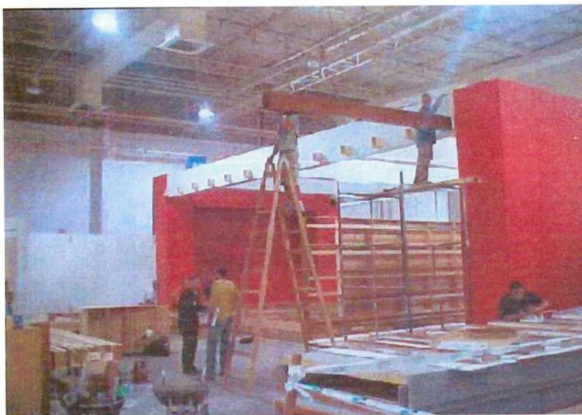
Figura 14 – Montagem do teto (Arquivo pessoal)
