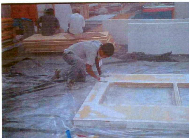
Figura 11 – Lixamento da massa (Arquivo pessoal)
