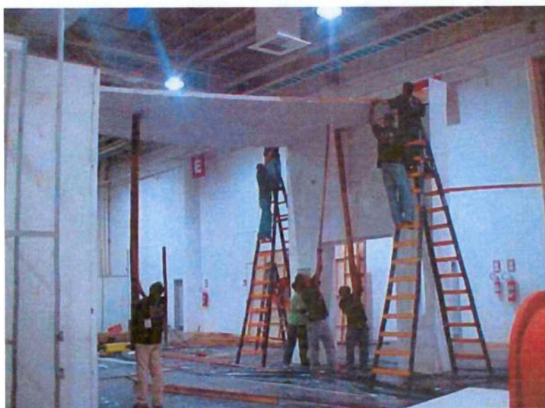
Figura 23 - Desmontagem do teto até seis metros, sem uso de andaimes e EPI's (Arquivo pessoal)
