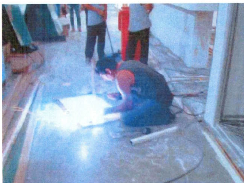
Figura 9 – Soldagem de estrutura metálica (Arquivo pessoal)
