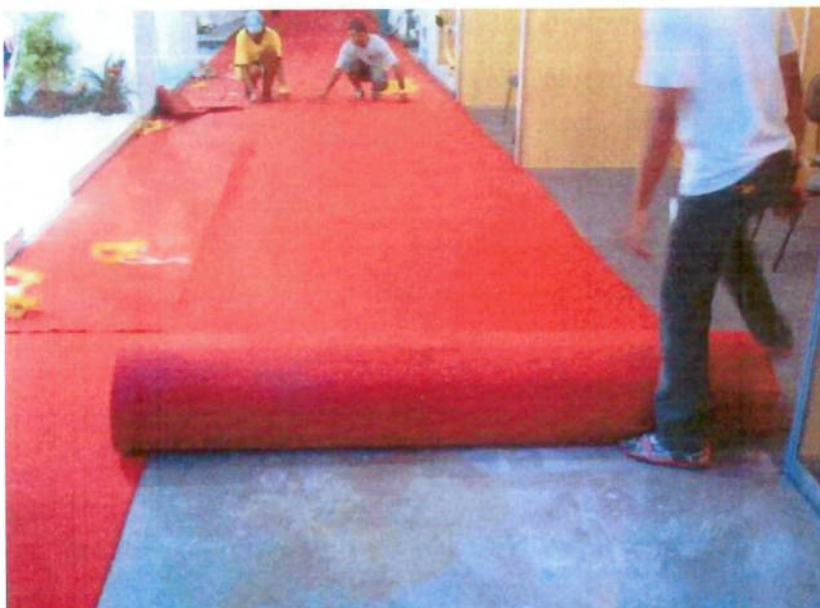
Figura 19 – Instalação de carpete (Arquivo pessoal)
