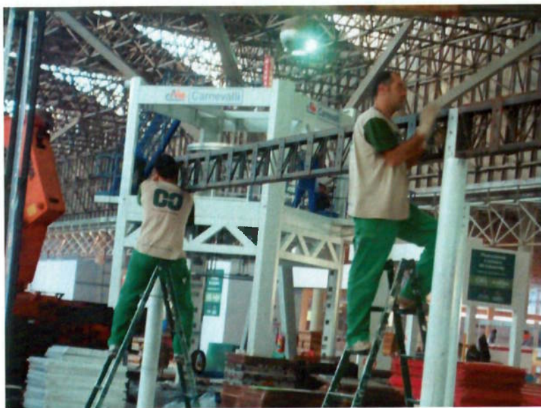
Figura 24 – Desmontagem do teto até três metros, sem uso de andaimes e EPI's (Arquivo pessoal)
